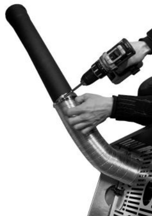
Fig. 61 - Buis met diam. 80 mm aansluiten
