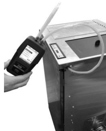
Fig. 70 - Aansluiting digitale drukregelaar
