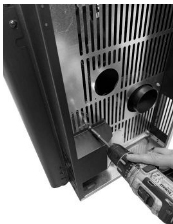
Fig. 55 - Verwijdering omleider
