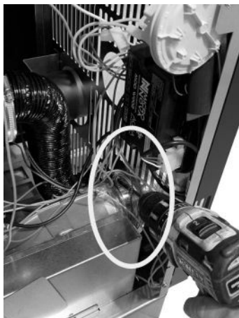
Fig. 60 - Flexibele buis vastzetten
