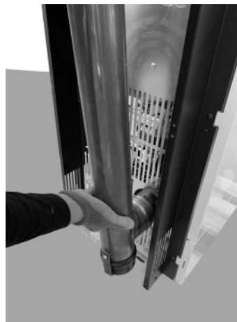
Fig. 41 - Buis met diam. 80 mm aansluiten
