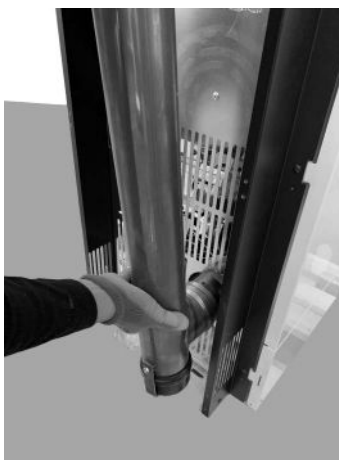
Fig. 47 - Buis met diam. 80 mm aansluiten
