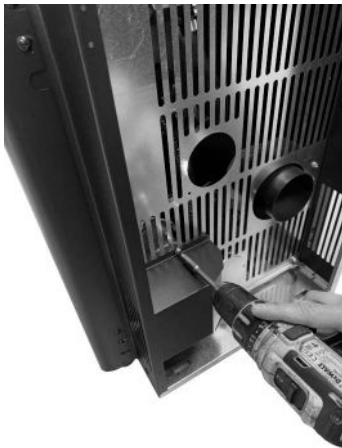
Fig. 57 - Verwijdering omleider
