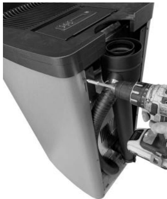
Fig. 29 - Achterste schroeven verwijderen
