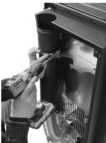
Fig. 63 - Buis met diam. 80 mm vastzetten
