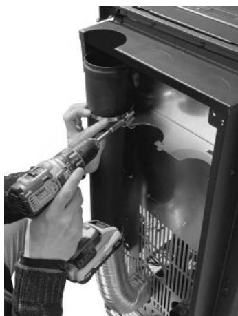
Fig. 63 - Buis met diam. 80 mm vastzetten
