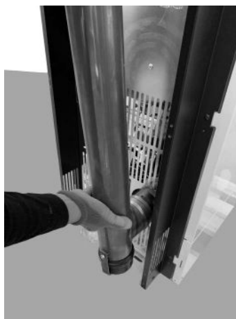
Fig. 47 - Buis met diam. 80 mm aansluiten
