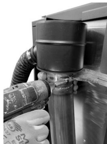
Fig. 48 - Vastzetten met buisklem
