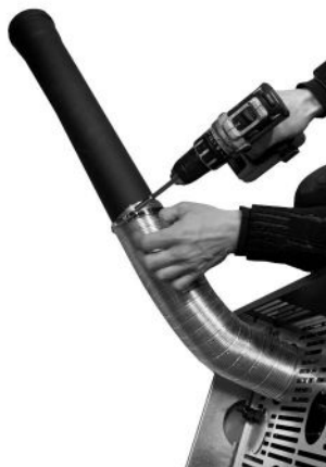
Fig. 61 - Buis met diam. 80 mm aansluiten
