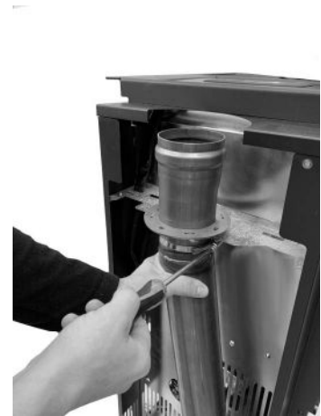
Fig. 42 - Vastzetten met buisklem
